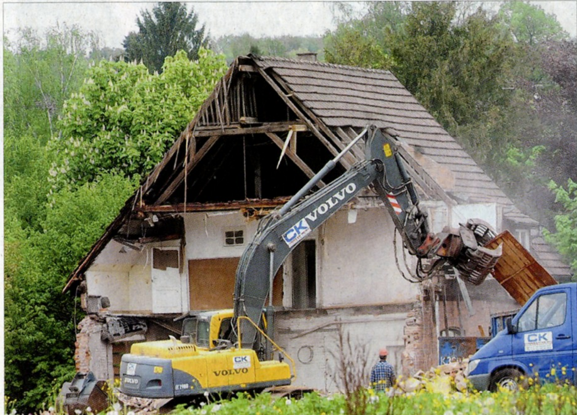
Auf dem Kauffmann-Gelände in Ebersbach rücken die Bagger an, um Häuser abzureißen. Hier soll eine neue Mitte zum Einkaufen und Verweilen entstehen. Ein Mieter ist jetzt jedoch abgesprungen. Foto: Giacinto Carlucci
