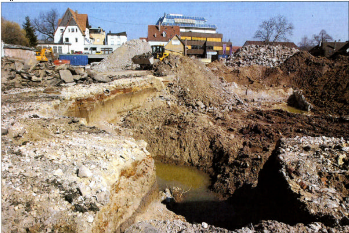
Erde und Schutt, soweit das Auge reicht. In der Ebersbacher Stadtmitte klafft ein Loch, das einer Mondlandschaft gleicht.
