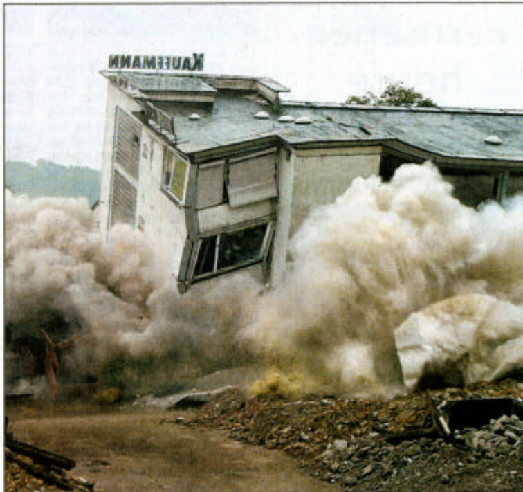
In Schiefelage: Das ehemalige Büro- und Produktionsgebäude wurde mit rund 50 Kilogramm Sprengstoff zu Fall gebracht. FOTOS: GILBERT KÜBLER (3)
